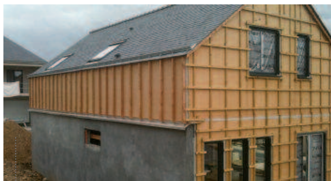
La maison bénéficie d'une isolation renforcée en ouate de cellulose.
